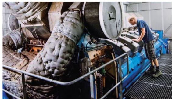
天然ガスを照明用の電気に変換する発電機をチェックするトマト生産者。副産物である熱とCO2を回収し、温室を暖め、植物の成長を促進するために使用します。
