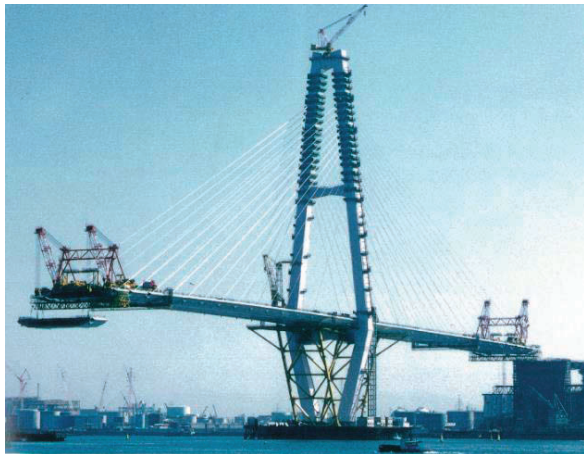
図4 バランシング架設工法
