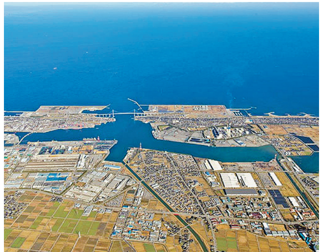
〈図7-15 伏木富山新湊地区（富山新港）〉
