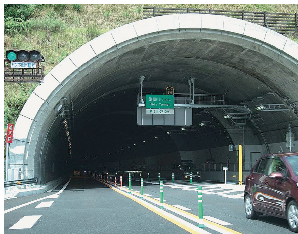
飛騨トンネル河合坑口
