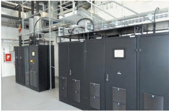
写真9 水素燃料電池、蓄電池、キャパシタから成るシステム
