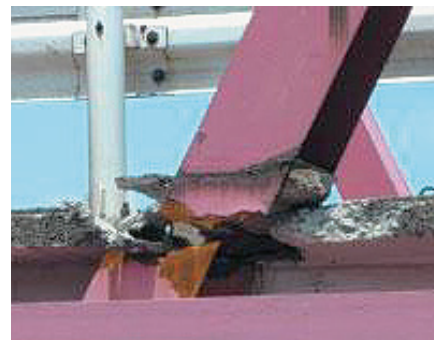
資料1：木曾川大橋（上り）損傷状況及び応急対策斜材破断部（国土交通省中部地方整備局三重河川国道事務所HPより）
