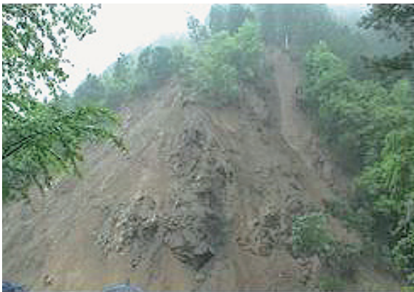
資料2：揖斐川町東横山地すべり崩壊箇所（国土交通省中部地方整備局越美山系砂防事務所HPより）
