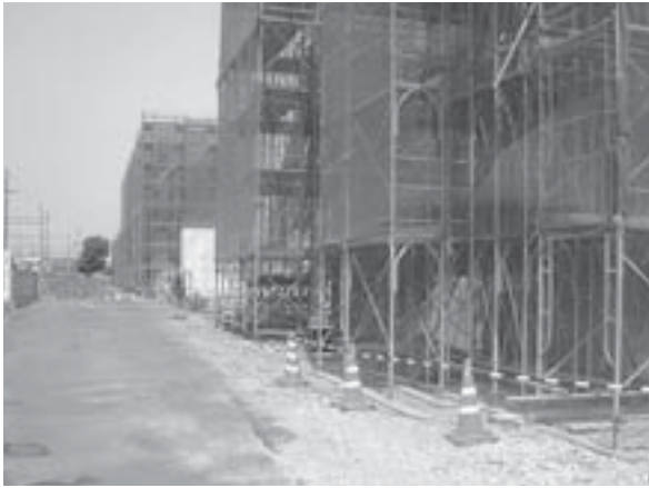
資料6 北陸新幹線の高架部建設が白山車両基地付近で始まった
