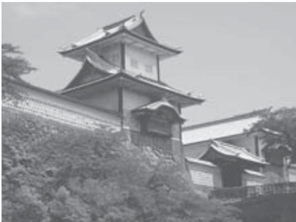
資料7 金沢城のシンボルとも言うべき石川門は重要文化財に指定。城内は五十間長屋や河北門が復元されている
