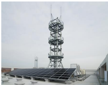
鈴鹿中央消防署（三重県鈴鹿市）
