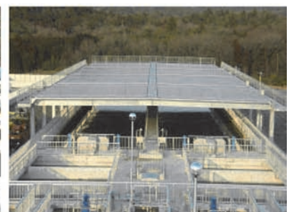
ゆめが丘浄水場（三重県伊賀市）
