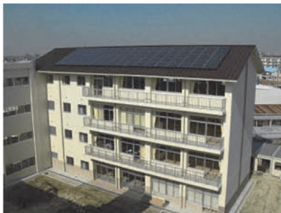
安城南中学校（愛知県安城市）
