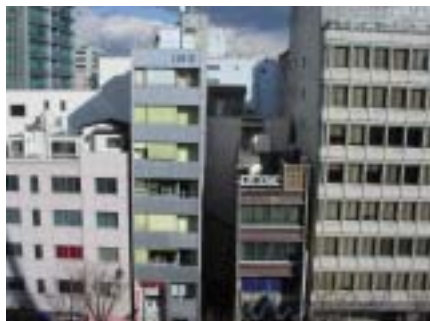
久屋大通り沿いのペンシルビル
