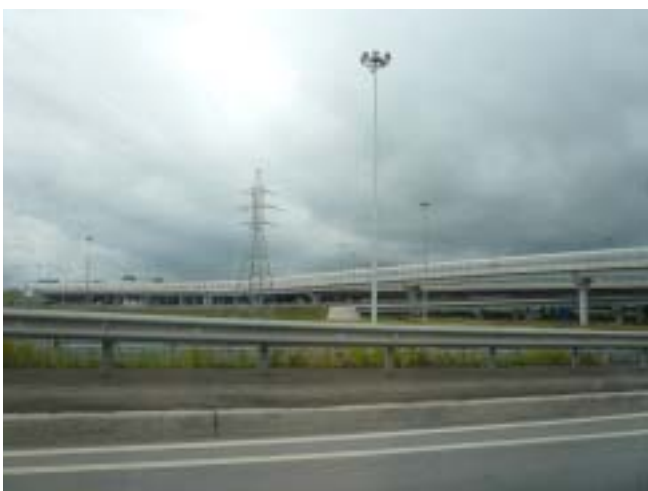
サンクトペテルブルグ市内の高速道路
